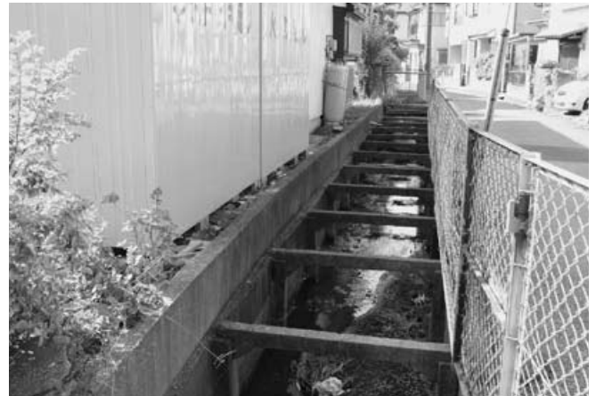
△関戸浮張団地内の外周排水路
