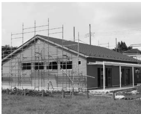
△建設中の蓮田ねがやど学童保育所
