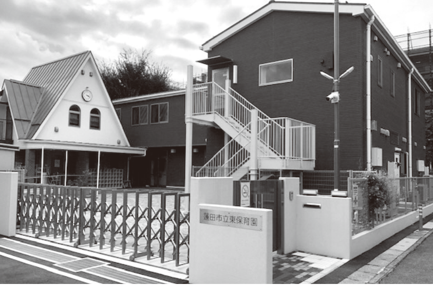
改築工事が完了した東保育園
