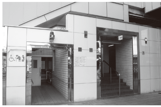
蓮田駅東口トイレ
