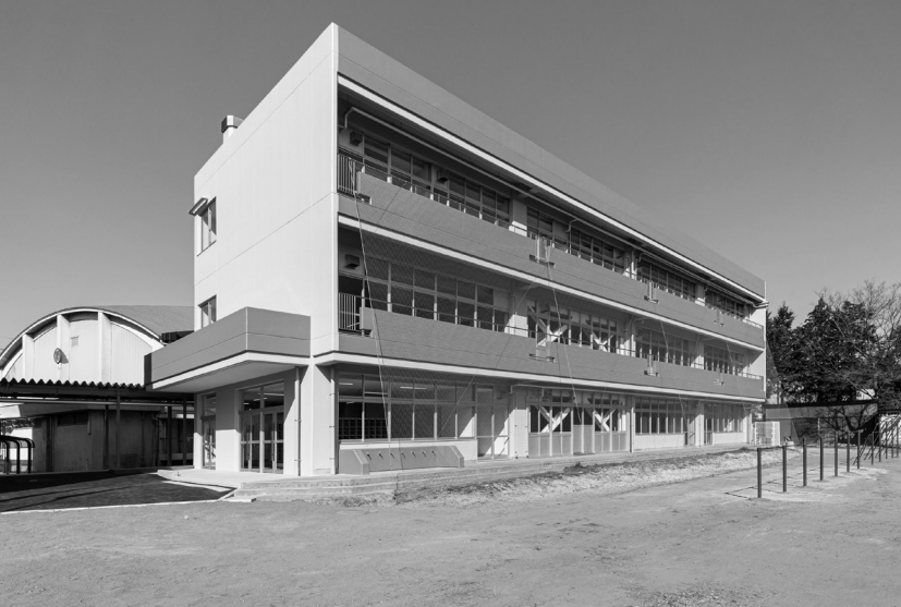
長寿命化改修工事を完了した黒浜中学校東校舎
