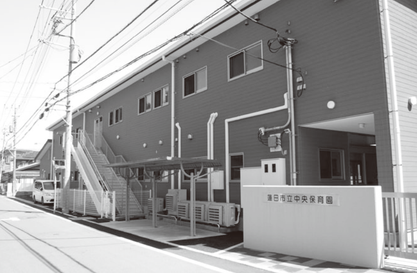
建替工事が完了した中央保育園
