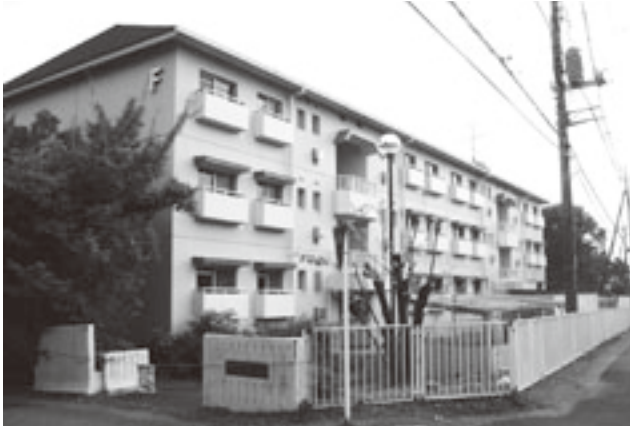
旧埼玉県立小児医療センター公舎（蓮田4丁目地内）
