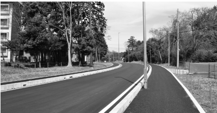
整備中の市道1472号線
