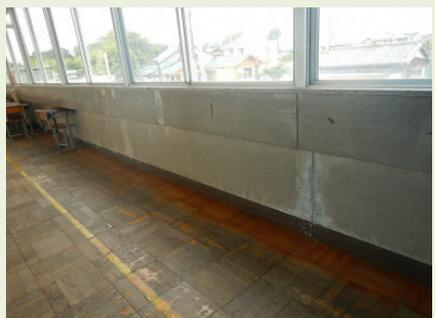
漏水痕を伴う壁のひび割れ
