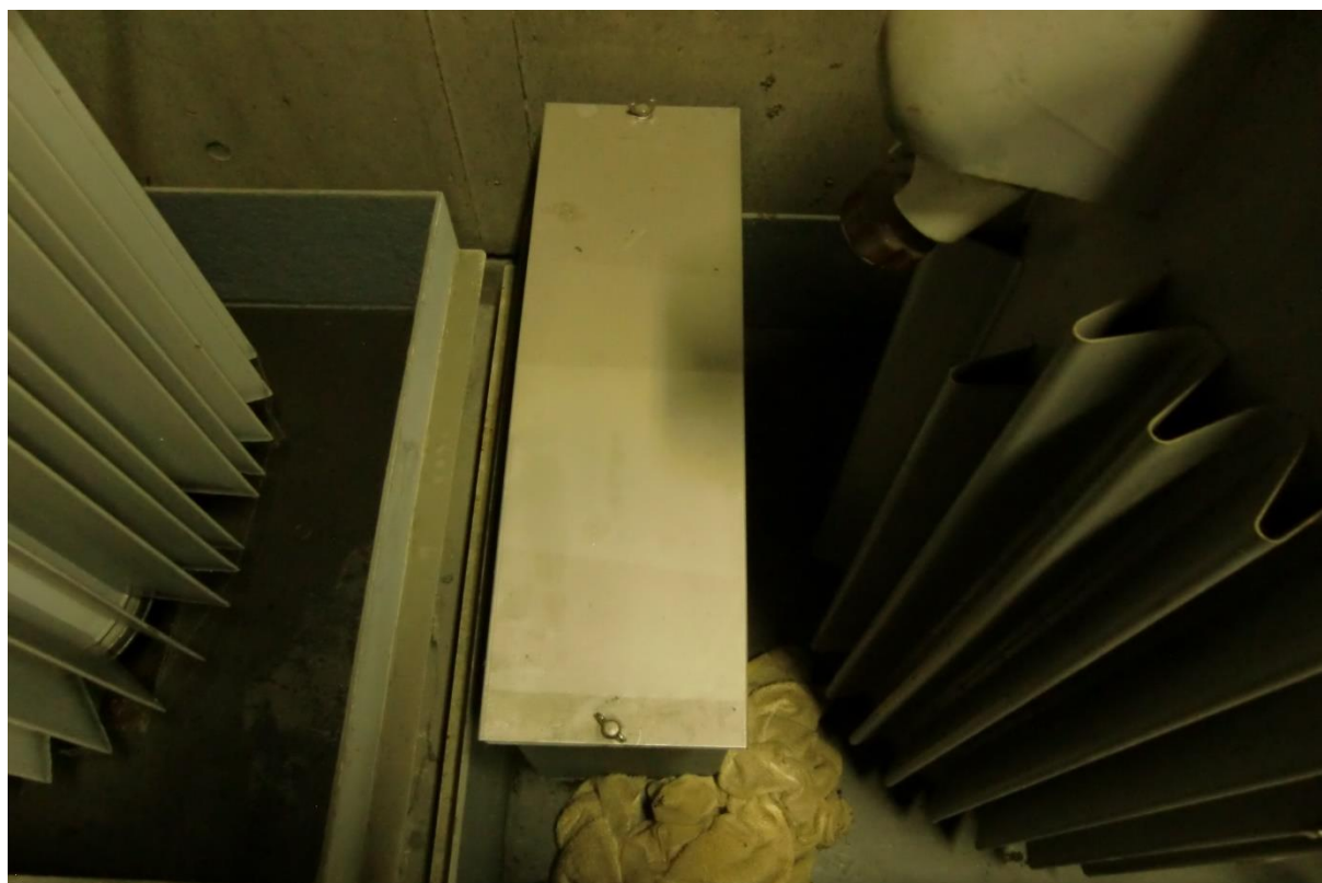
高濃度 P C B 廃棄物保管箱（市役所庁舎）
