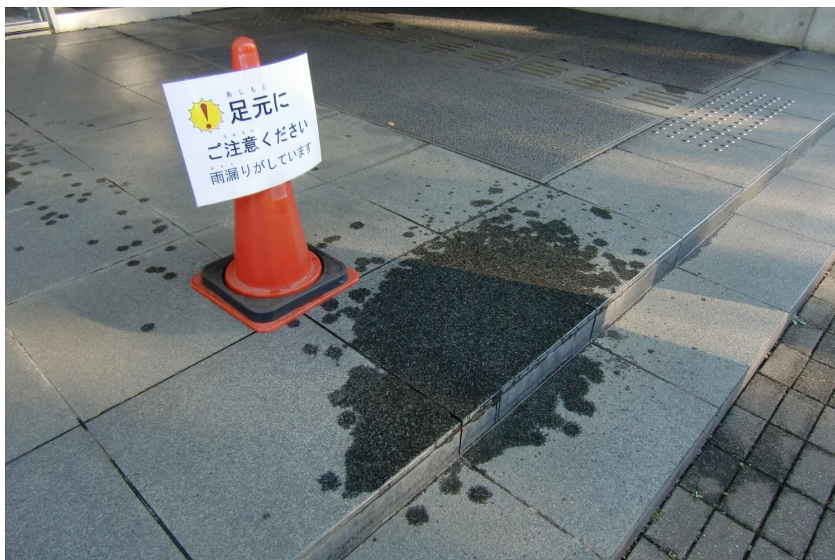
雨漏り（図書館正面玄関）
