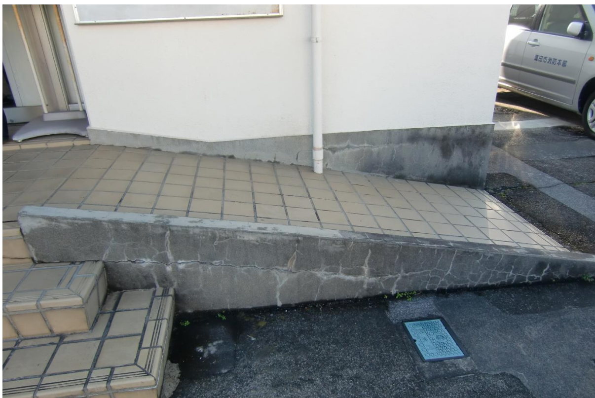
傾斜が急で手すりがないスロープ（消防署南分署）
