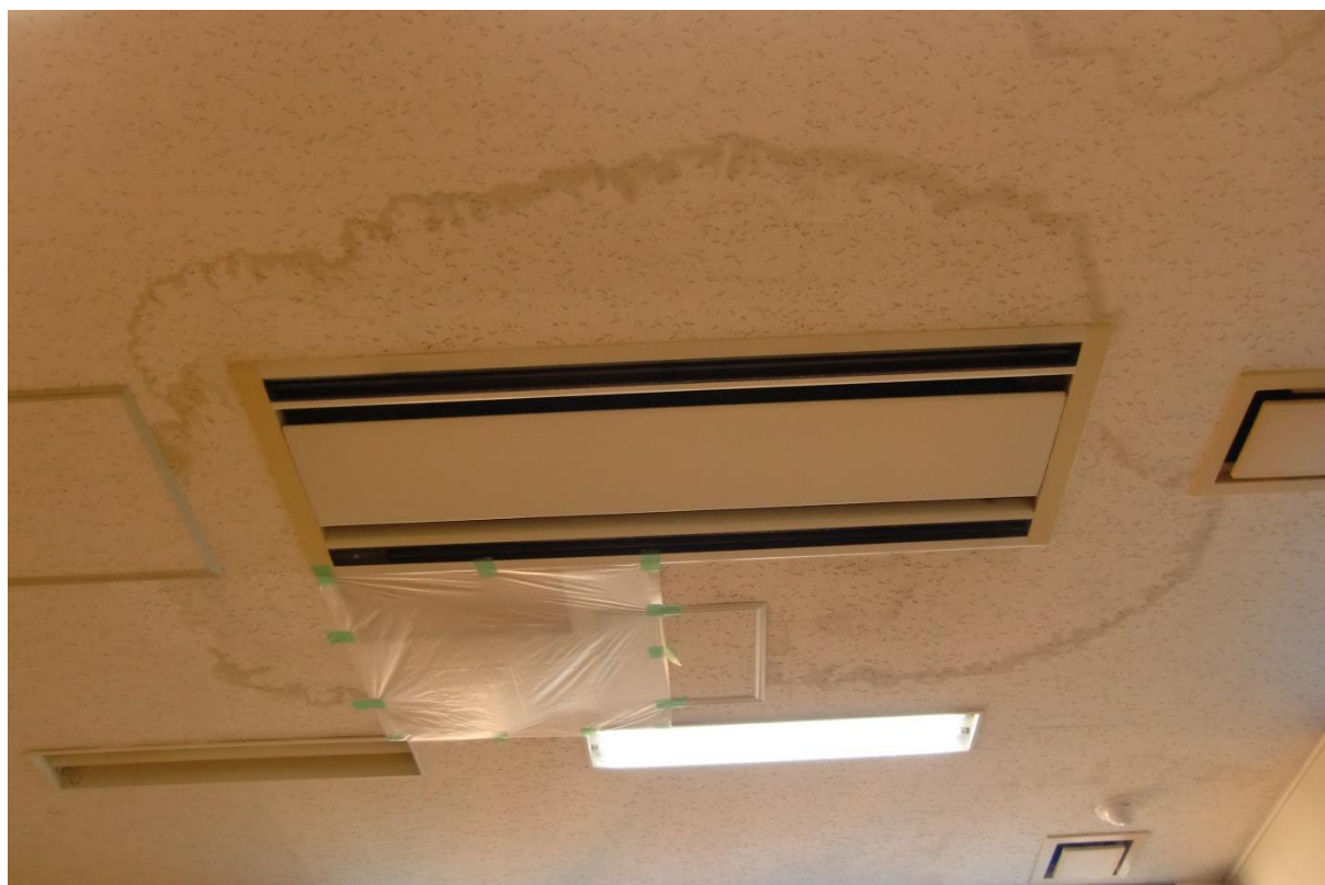
雨漏り（勤労青少年ホーム軽体育室）
