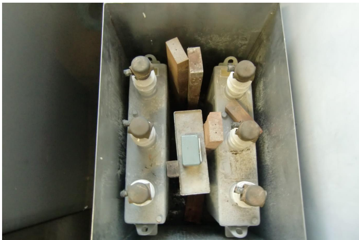
PCB廃棄物保管箱中身（コンデンサ、上下水道部庁舎）
