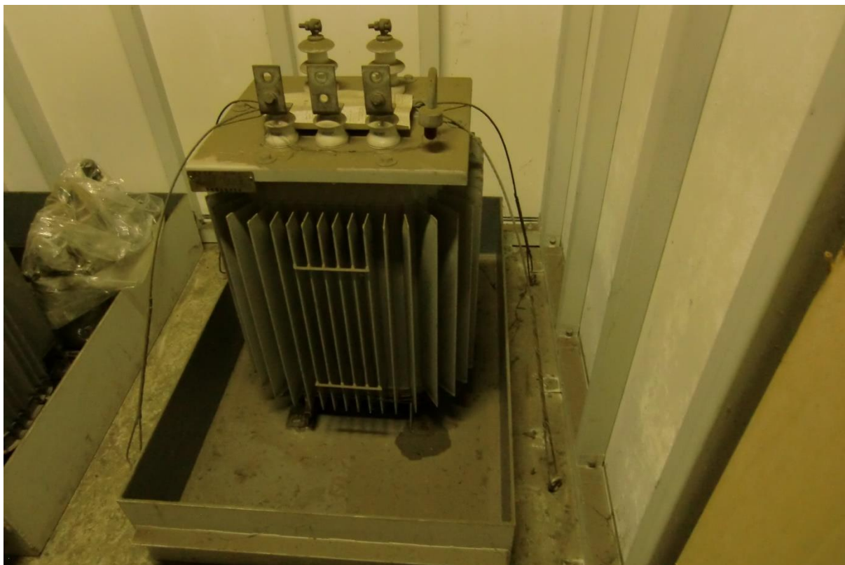
低濃度 P C B 廃棄物（トランス、市役所庁舎）
