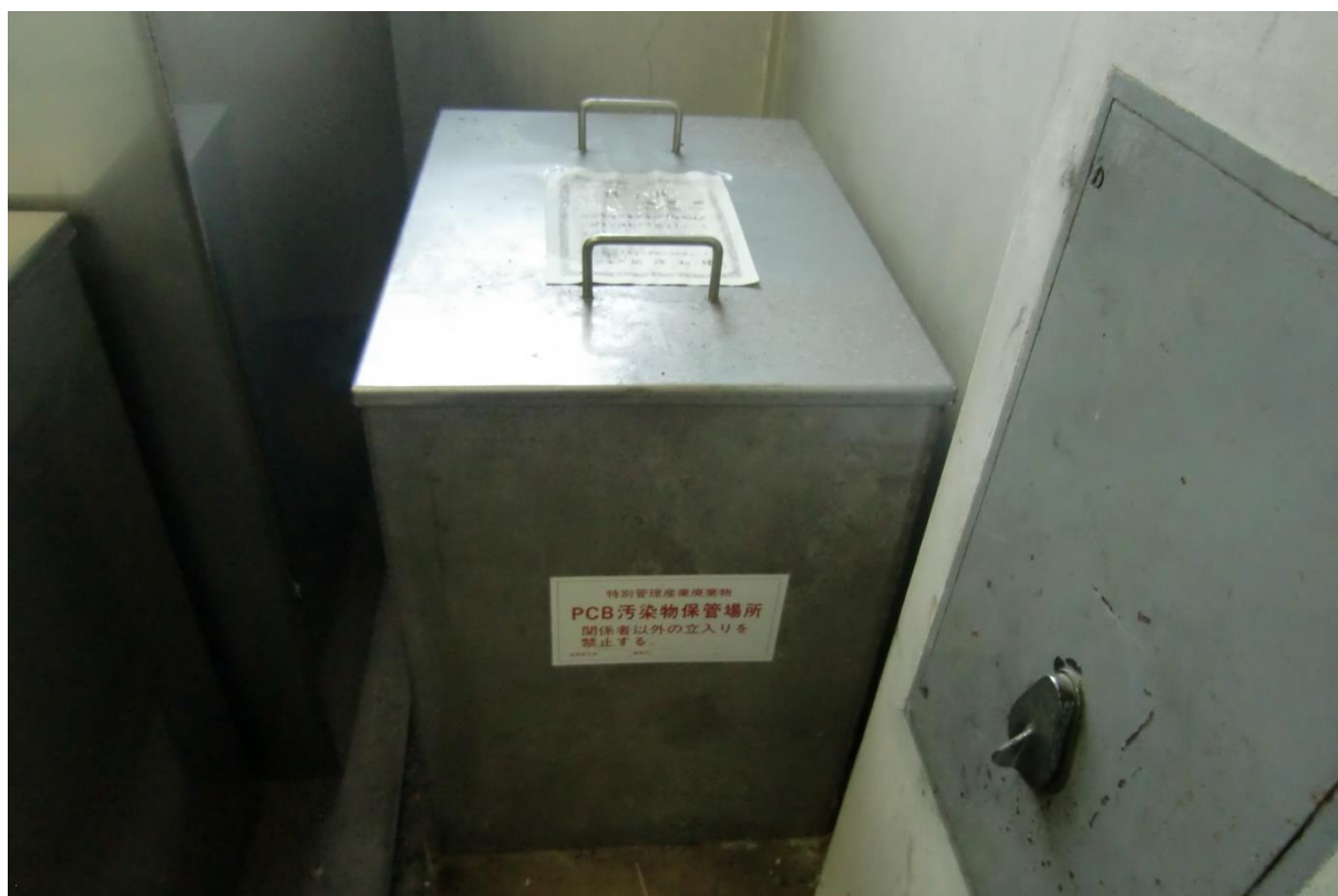
PCB廃棄物保管箱（上下水道部庁舎）
