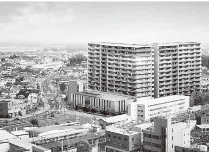
蓮田駅西口第一種市街地再開発事業 市の公益施設等の権利床等整備費負担金、再開発ビルの施設や駐車場等の共用部分に対する特定建築者補助金など、再開発ビル建設に伴う関係経費を計上しています。平成32年10月の再開発ビルの完成に向け、いっそうの進捗を図ります。
