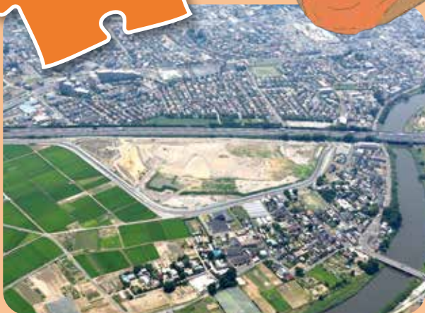
■ 川島地区に建設中のサービスエリア
