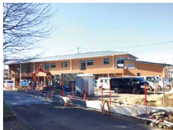
中央保育園の改修工事
