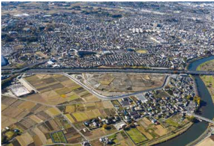
蓮田サービスエリア（新上り線） 工事の様子
