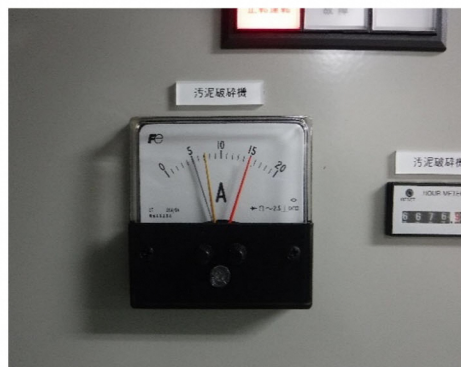
確認部品：電流値 状況：5.0A ( \leq 15A ) \rightarrow 5
