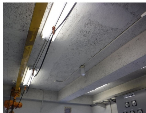
確認部品：1F天井部漏水状況 状況：漏水は見られない
