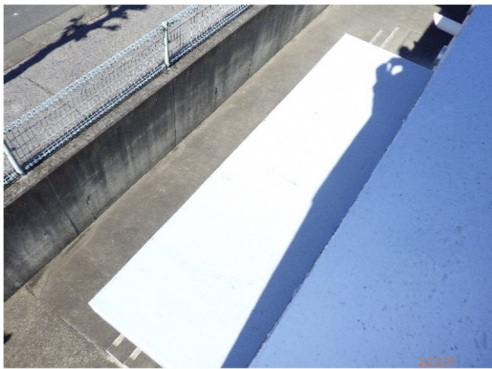
確認部品：屋根防水_底部2 状況：大きな異常は見られない
