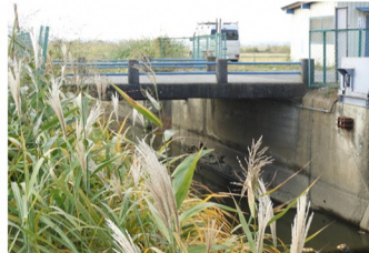
図 13 山王橋 (健全性 II) (大字江ヶ崎地内)
