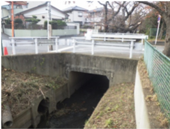
図 7 797-1号橋（3.0m） （関山三丁目地内）
