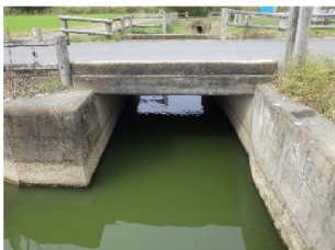
図 12 48-2 号橋 (健全性 I) (大字貝塚地内)
