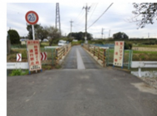
図 14 八幡（やはた）橋 (健全性 III) (大字馬込地内)
