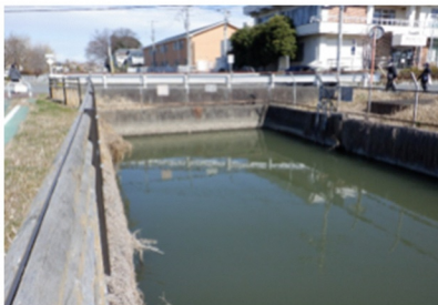
図 9 亀甲橋（水路） （見沼町地内）
