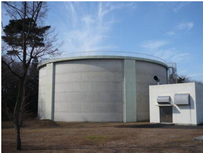
第3期拡張事業により新設した黒浜配水池場(平成5年竣工)
