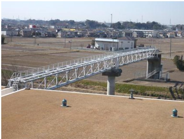
埼玉県企業局から浄水場に水を受水する水管橋
