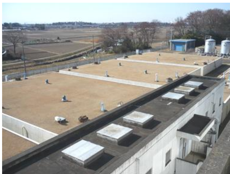
浄水場配水池遠景
