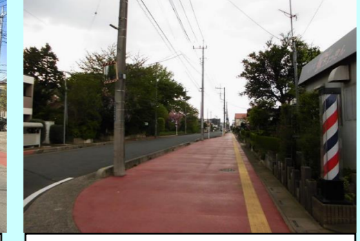
市道51号線歩道
