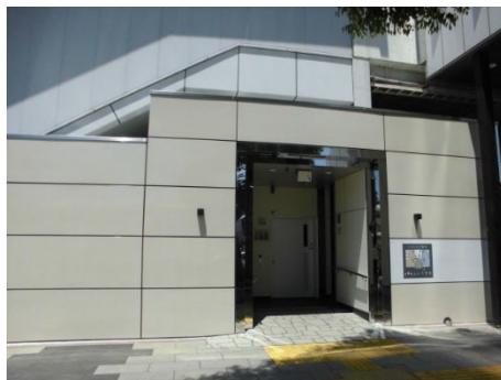
蓮田駅東口トイレ
