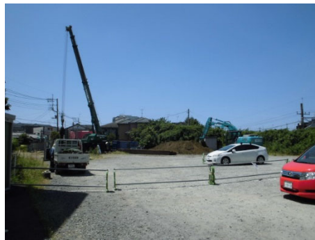
中央公民館駐車場（整備中）
