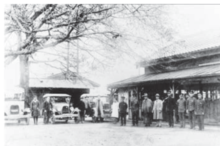
蓮田駅西口 (昭和8年)
