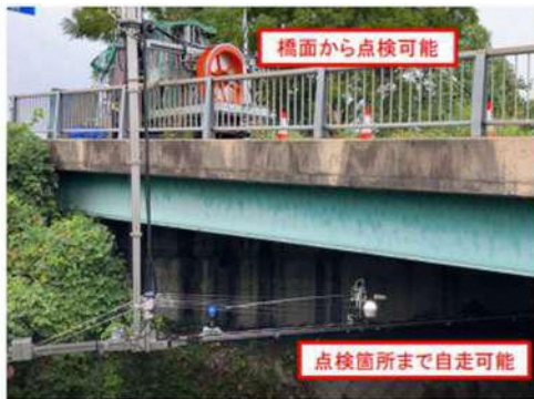
写真-1 点検状況
