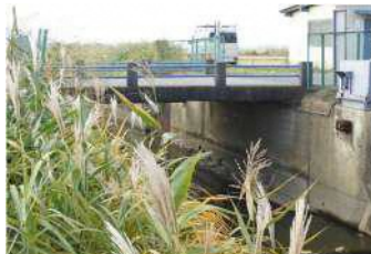
図 13 山王橋 (健全性 II) (大字江ヶ崎地内)
