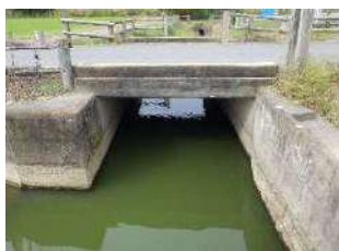
図 12 48-2号橋 (健全性 I) (大字貝塚地内)
