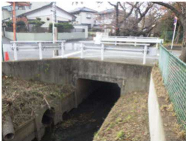
図 7 97-1号橋 (3.0m) (関山三丁目地内)
