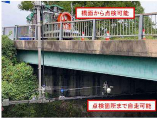
写真-1 点検状況
