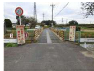
図 14 八幡（やはた）橋 (健全性 III) (大字馬込地内)
