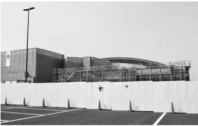
建設中の総合市民体育館サブアリーナ
