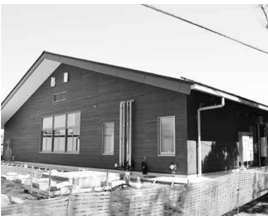
建設中の環境学習館
