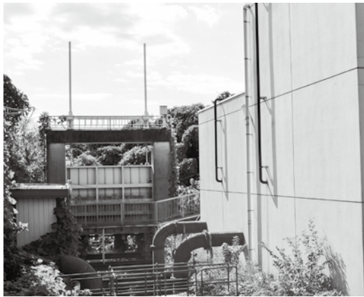
西新宿地区第一排水機場
