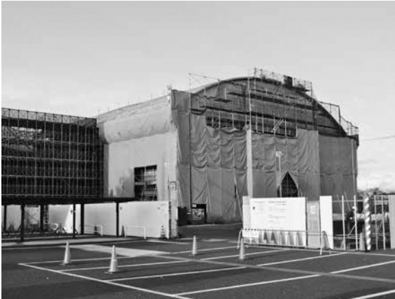
増築工事中のサブアリーナ
