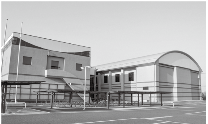
大規模改修工事が終了したパルシー(左)と増築されたサブアリーナ(右)
