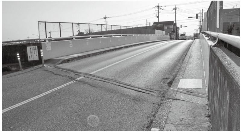
人道橋整備が望まれる宿浦橋（大字黒浜地内）
