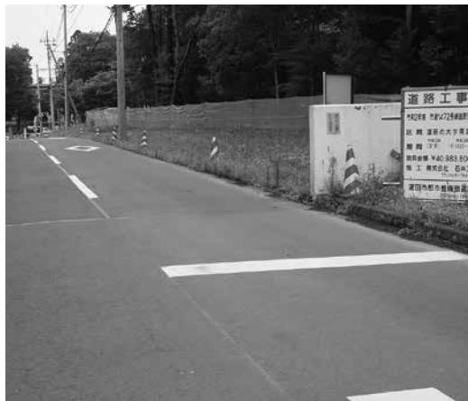
市道1472号線工事現場 (東埼玉病院出入口付近)
