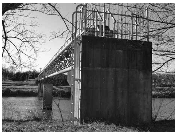
元荒川に架かる水管橋
