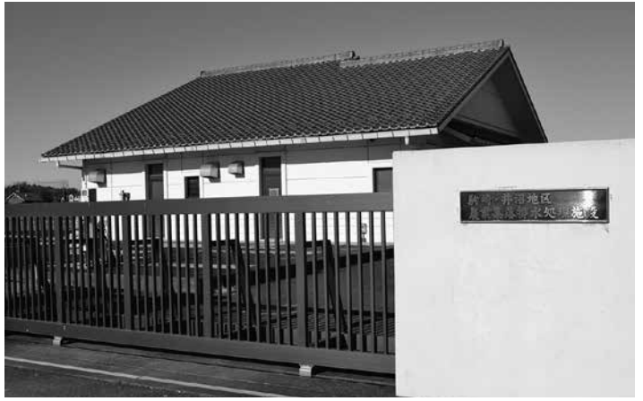
駒崎・井沼農業集落排水処理場
