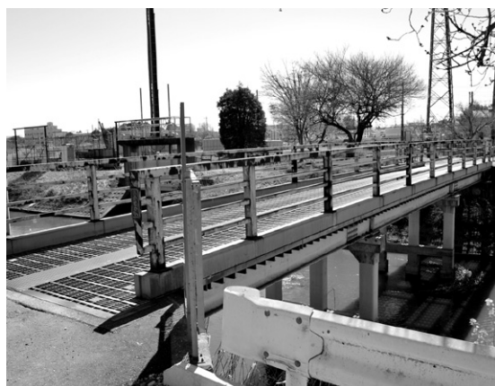
架け替え予定の八幡橋（大字馬込地内）
