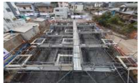
黒浜小学校給食棟改築工事(Ⅰ期)
