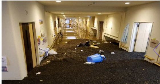
施設1階に土砂が大量に流入したが、全員無事 写真提供: 静岡県小山町
