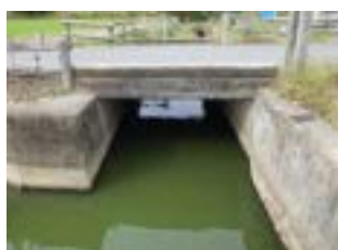
図 2.8 48-2 号橋 (健全性 I) (大字貝塚地内)
