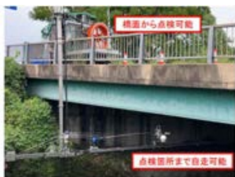
写真-1 点検状況
