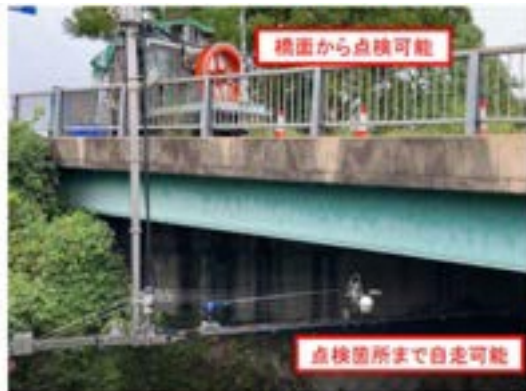
写真-1 点検状況
