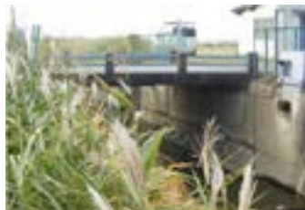
図 2.9 山王橋 (健全性 II) (大字江ヶ崎地内)
