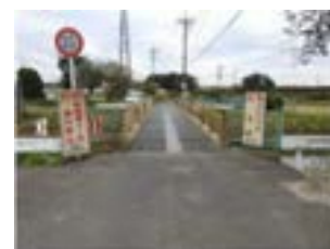
図 2.10 八幡（やはた）橋 (健全性 III) (大字馬込地内)
