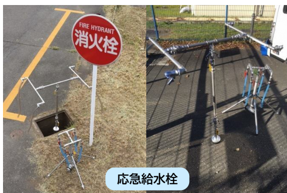
図 3.14 応急給水に使用する資機材の一例
