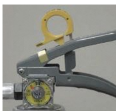
× 安全栓の抜けかけ
