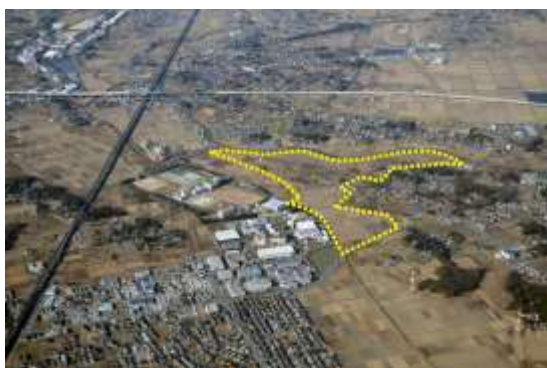
高虫西部地区（産業団地整備予定地）
