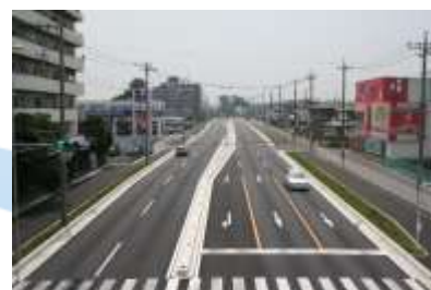
平成 18 年 国道 122 号バイパス開通
