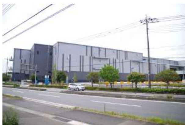
根金地区の倉庫
