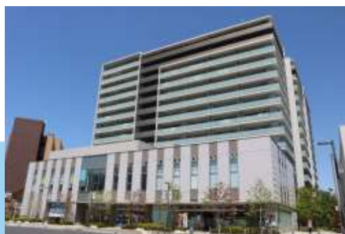
令和 2 年 蓮田駅西口再開発ビル竣工
