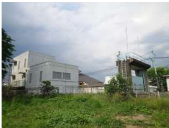
西新宿地区第一排水機場
