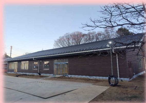
工事中の環境学習館(令和7年1月28日撮影)
