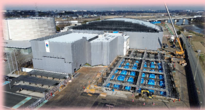
工事中の総合市民体育館及びサブアリーナ (令和7年1月28日撮影)
